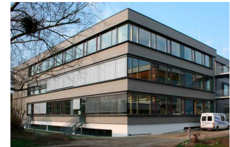
Realschule Buchloe, Bayern m2s müller.schurr.architekten, Anton Ambros GmbH, TES EnergyFacade Bildquelle: https://www.ambros-haus.de/zukunftsweisende-schulsanierung.html
