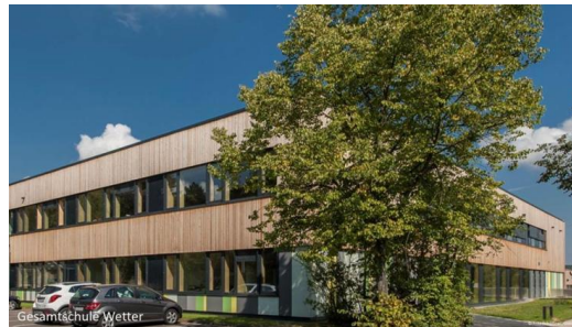
Gesamtschule Wetter, Hessen m2s müller.schurr.architekten, Rubner Holzbau, C+P - Christmann & Pfeifer Construction, TES EnergyFacade Bildquelle: https://www.zukunftaltbau.de/fileadmin/user_upload/Veranstaltungen/Herbstforum_Altbau_2019/Referenten/Vortraege/Herbstforum_Altbau_Jochen_Schurr_Serielle_Schulsanierung_27112019_Downloadfreigabe.pdf
