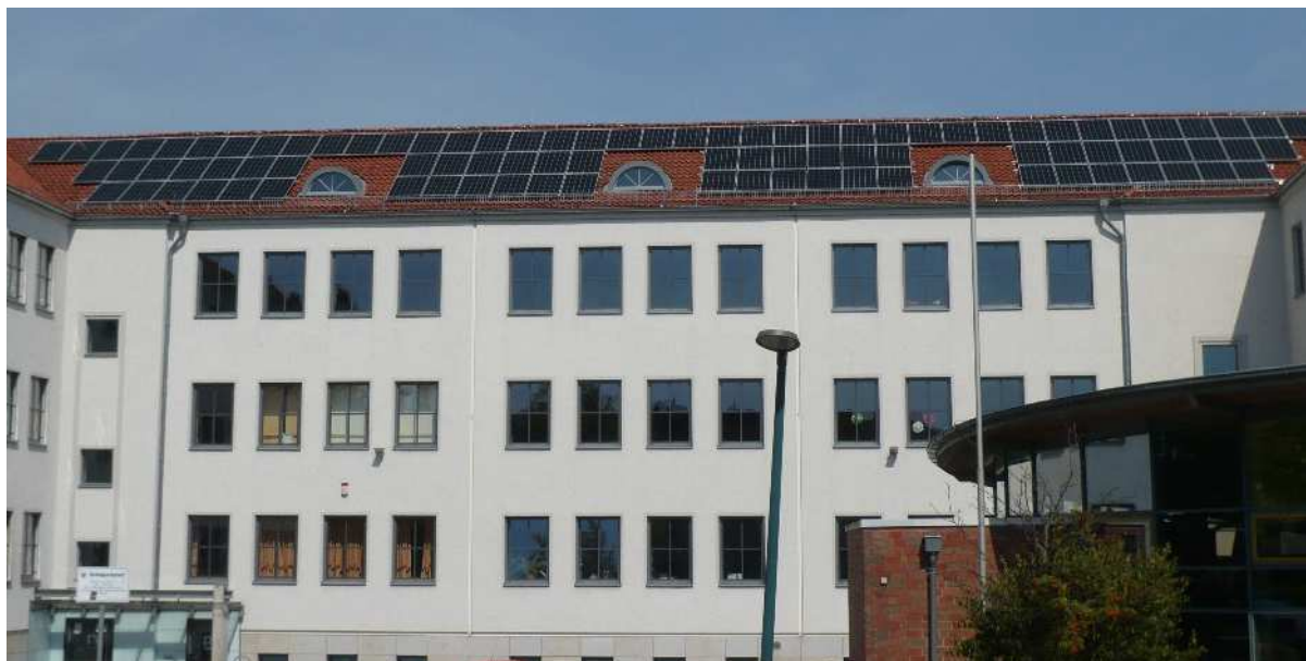
Ansicht der PV-Anlage auf der Oberschule in Bückeberg
