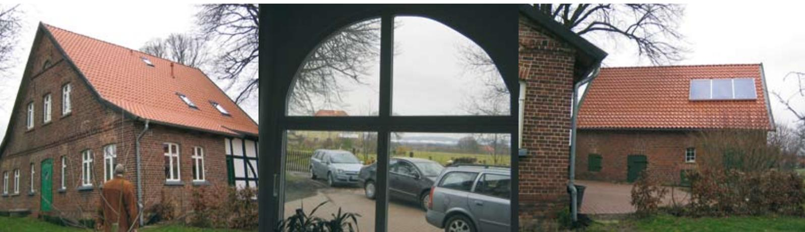
**Maßnahmen:** Der schlechte Bauzustand machte umfangreiche Reparaturen sowie die Erneuerung von Bauteilen erforderlich, die mit der unteren Denkmalbehörde abgestimmt wurden. Hierbei wurden die Struktur und Substanz des Gebäudes erhalten, Außenflächen von innen gedämmt, neue Holzfenster eingesetzt und ein solarunterstützter Gasbrennwertkessel installiert.
