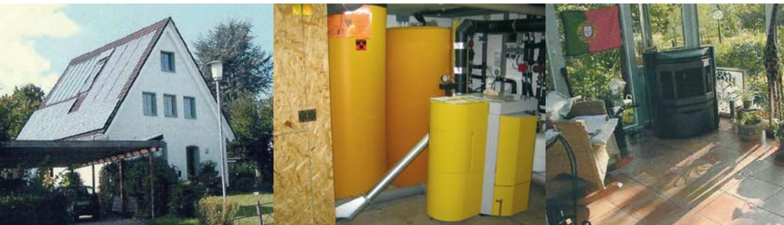
**Maßnahmen:** Ein Maßnahmenswerpunkt lag auf der Nutzung erneuerbarer Energiequellen. Bereits 1988/89 wurden Solaranlage sowie Kachelofen installiert, sodann diese 1994/2002 um Photovoltaik, 2002 um Pelletkaminofen und 2005 um Pelletzentralheizung erweitert. Nach Ausbau und Dämmung des Dachgeschosses 1994 wurden 2004 der Wintergarten angebaut und schließlich 2005 die Außenwände und Fenster grundlegend modernisiert.
