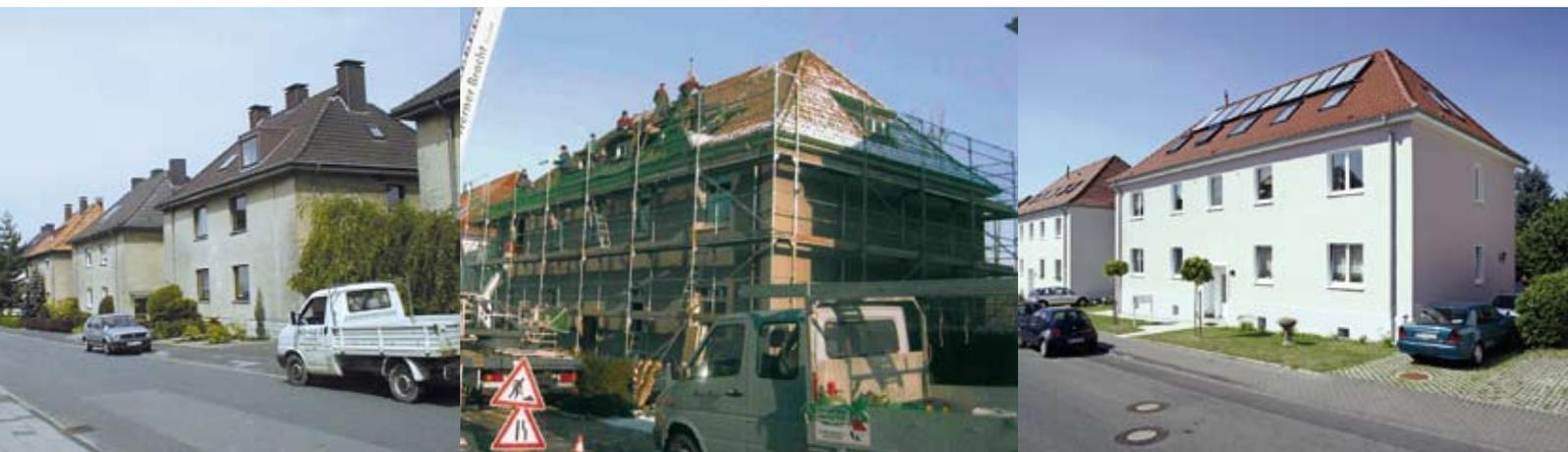
**Maßnahmen:** Das Quartier wurde im Zeitraum 1998 bis 2005 in zwei Zyklen komplett saniert. Das Gebäude Nr. 55 wurde im zweiten Zyklus modernisiert, wobei das Dach neu gedeckt, Dach, Wände, Fußböden zum Keller gedämmt, Fenster erneuert sowie ein solarunterstützter Gasbrennwertkessel installiert wurden.
